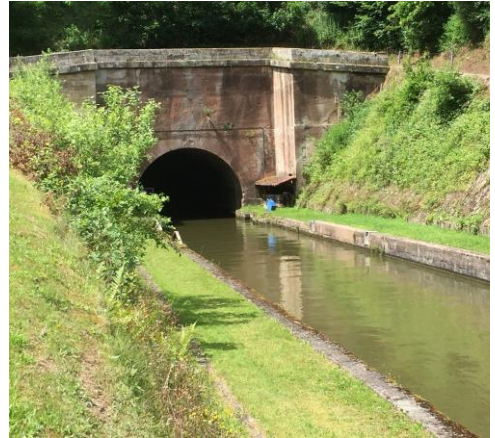
Tunnel Canal Marne au Rhin
